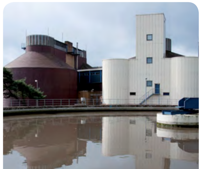
Abbildung 25: Regenüberlaufbecken und Faultürme im Hintergrund, Foto: Christian Schaum
