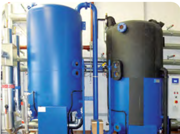
Abbildung 40: Zentralklärwerk Darmstadt, Absorptionskältemaschine, Foto: Christian Schaum
