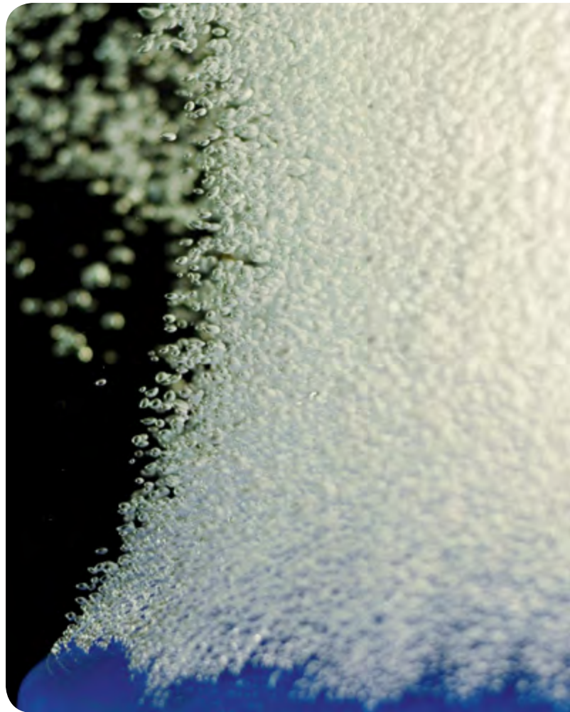
Abbildung 51: Die Belüftung ist der größte Energieverbraucher kommunaler Kläranlagen; hier: Sauerstoffeintrag durch Membrantellerbelüfter, Foto: Christian Schaum
