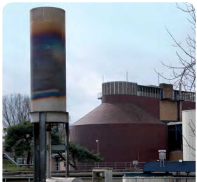
Abbildung 46: Die Nutzung der Gasfackel führt zur energetischen Ineffizienz und sollte zwingend vermieden werden! Foto: Christian Schaum
