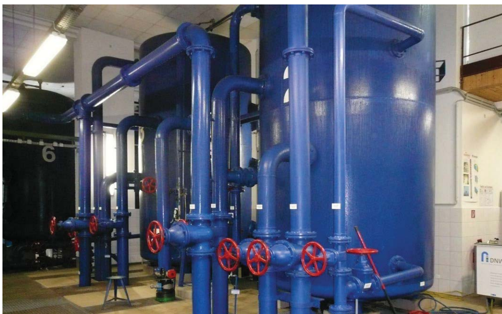
سالن فیلتراسیون شرکت آب Ludwigsfelde Filter hall of the Ludwigsfelde waterworks
